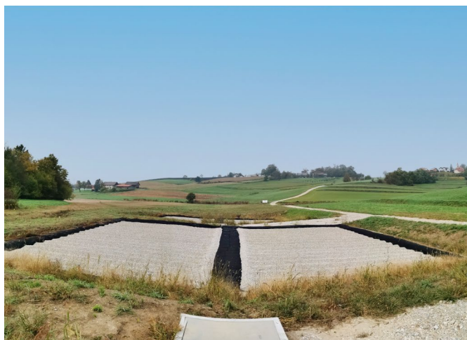
Vertikalna rastlinska čistilna naprava Raka (400 PE).
