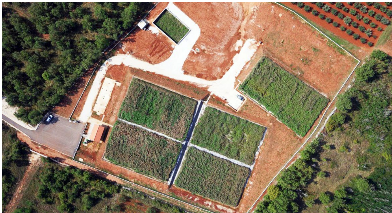
Rastlinska čistilna naprava Kaštelir (1.900 PE).
