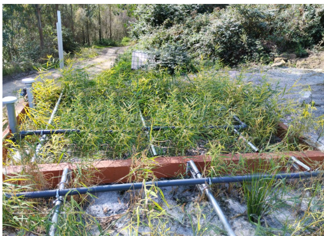
Aerirana rastlinska čistilna naprava za deponijo Xiloga v Španiji.
