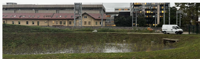
Vrbov sistem za čiščenje padavinske vode.
